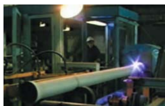
5. Участок нанесения цинкового покрытия
