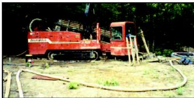
Рисунок 6.17 Прокладка трубопровода методом горизонтально направленного бурения.
