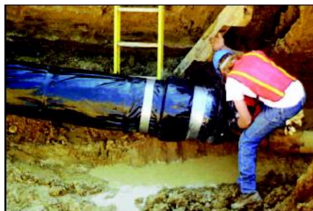
Рисунок 6.22 Покрытие труб полиэтиленовым рукавом.
