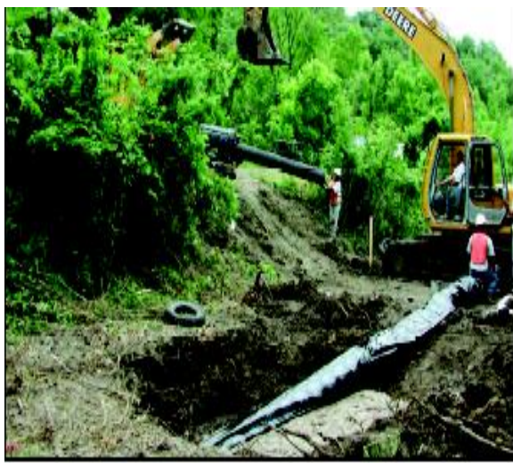
Рисунок 6.24 Картриджный метод укладки труб.
